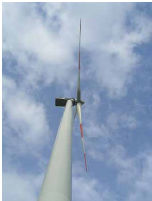
(Generatore eolico in Germani)
